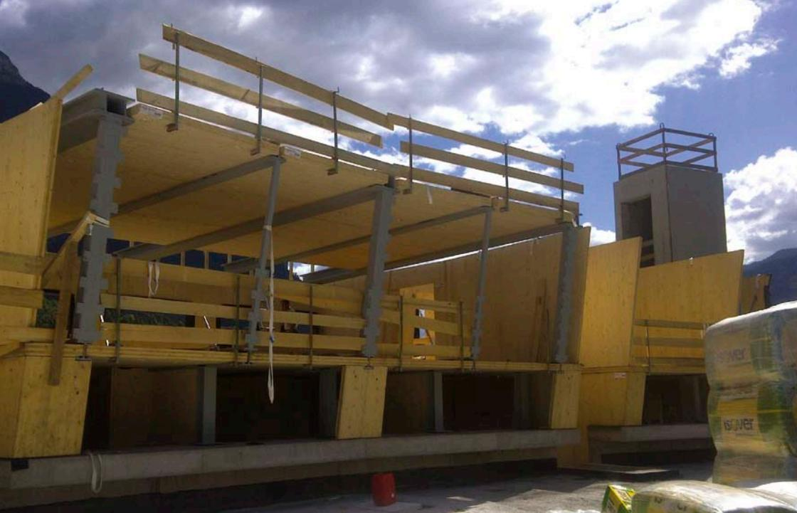
complessa, composta da elementi di solaio (compresa la copertura) e di parete in pannelli di legno ed elementi a telaio in acciaio.
